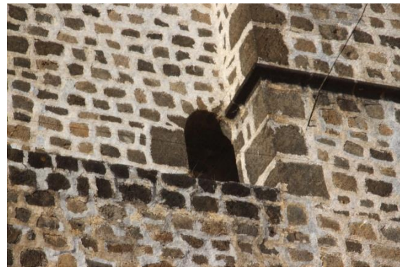
Paso de ronda sin almenado con paso de túnel.
