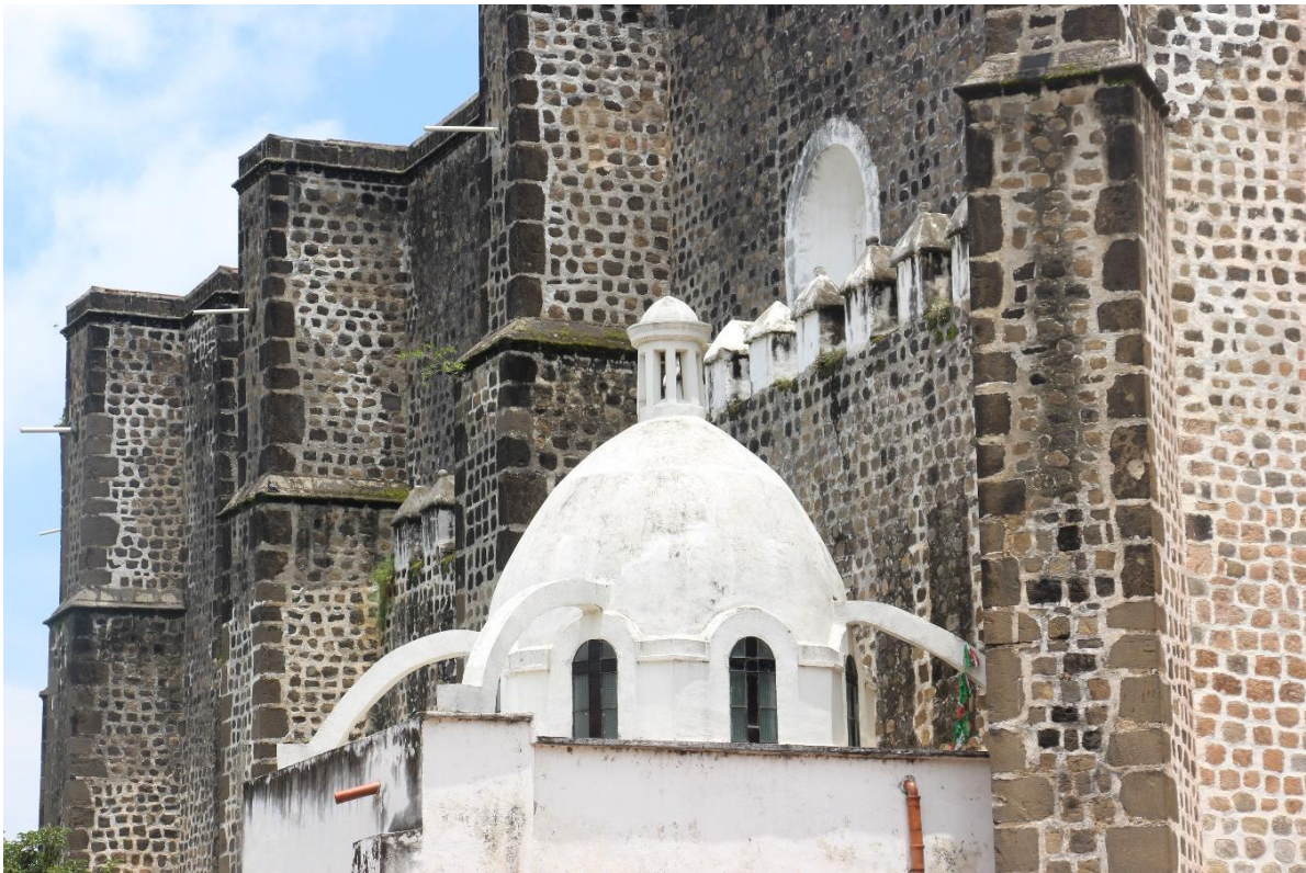
Contrafuertes de la fachada lateral Norte
