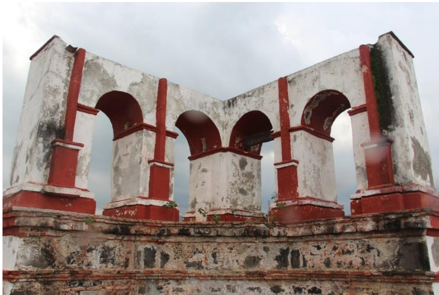
Espadaña vista por el interior de la azotea del templo
