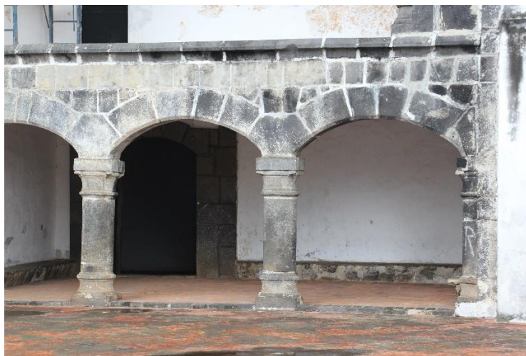
Pórtico de acceso al claustro llamado “Portal de peregrinos”
