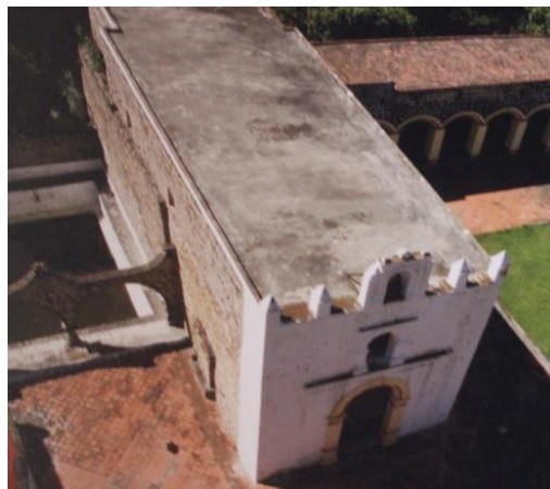
Vista aérea desde la torre se muestra el aljibe a la izquierda
