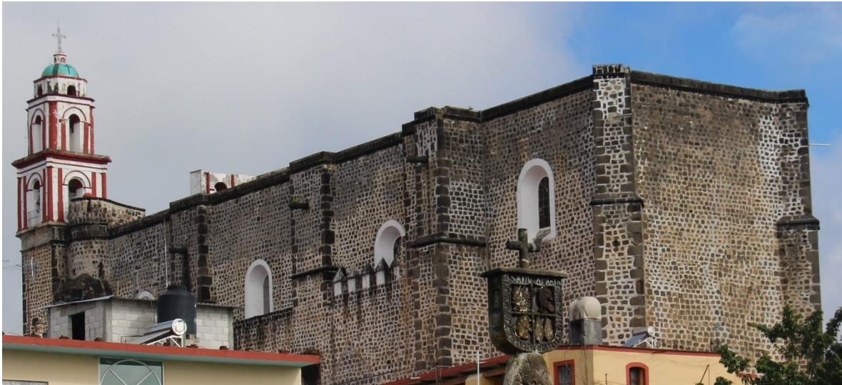
Contrafuertes de la fachada lateral sur y del ábside del templo.
