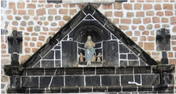
Frontón en la portada de la fachada principal
