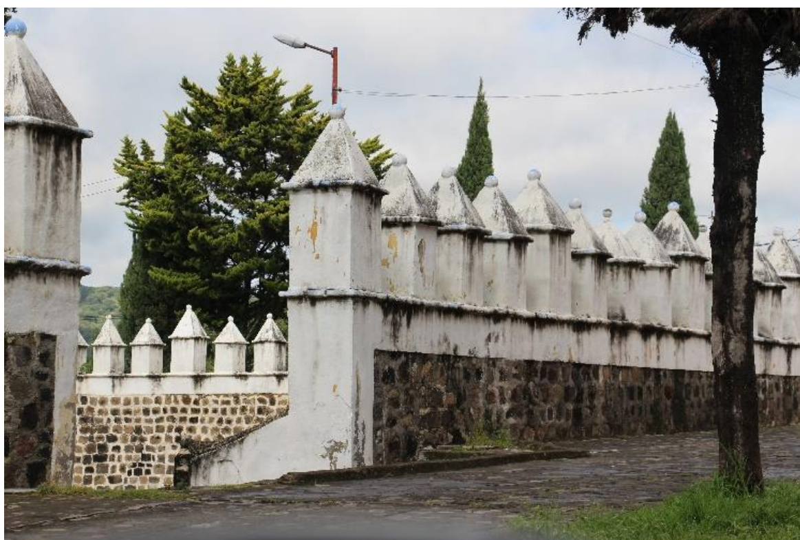
Acceso exterior del Atrio del Templo
