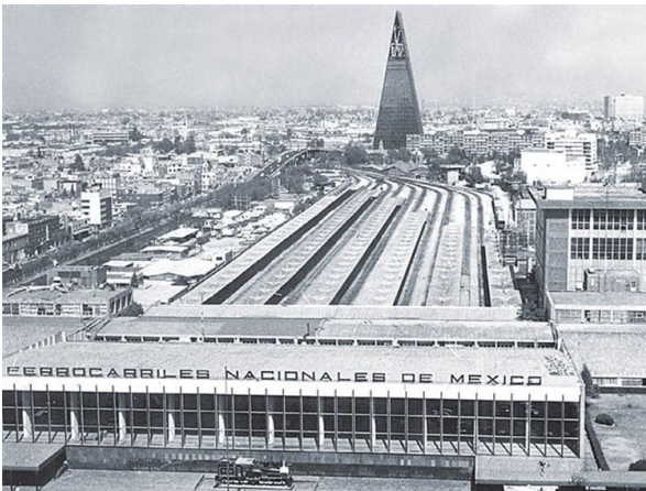
Imagen 19. La construcción de la Estación Buenavista, 1959, estuvo a cargo del arquitecto Jorge L. Medellín y se inauguró la nueva estación durante la presidencia de Adolfo López Mateos.
