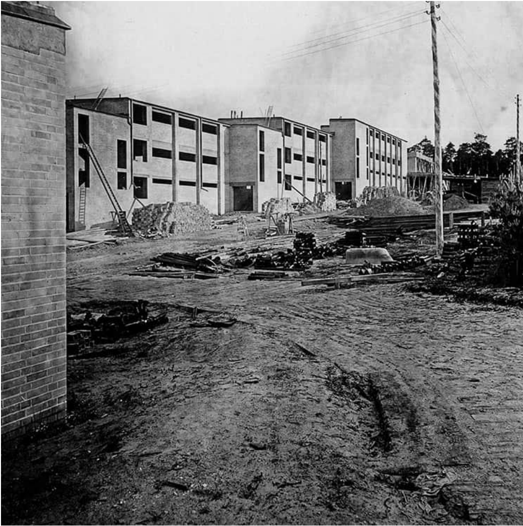
Imagen 34. Vista noroeste de los edificios residenciales A-E en construcción. Fuente: (Dokumentation-Bundesschule des ADGB, p.206)
