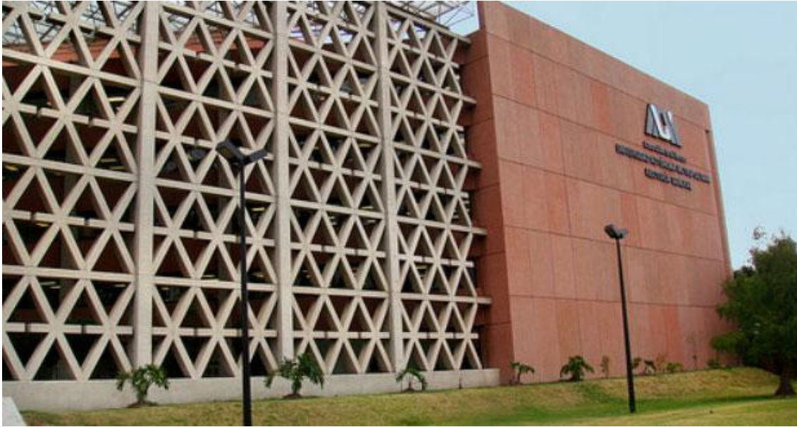
Imagen 10. Proyecto y construcción de la Rectoría General, Universidad Autónoma Metropolitana. 1993-1998, ubicación: Prolongación Canal de Miramontes no. 3855, Col Ex-Hacienda de Tlalpan, Delegación Tlalpan.
