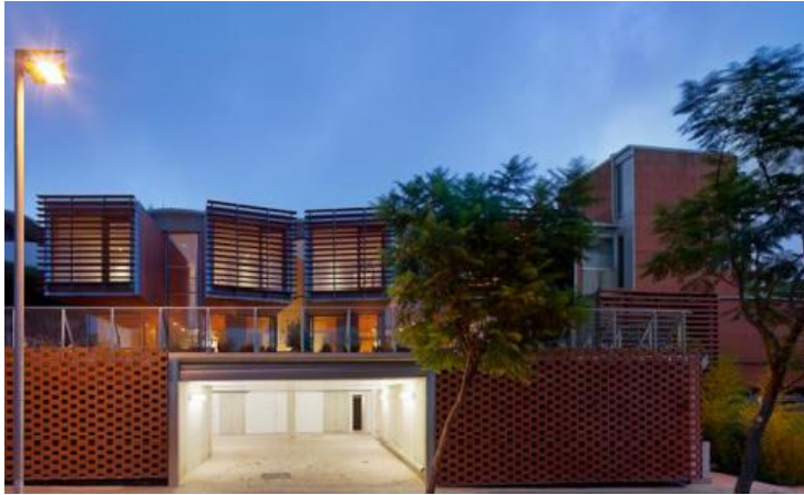
Figura 6. Fachada Norte-Este. Fuente: Cabezas 2012
