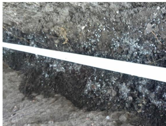
Figura 16. Polímero absorbente agregado a la tierra, 10cm. alrededor del tubo.
