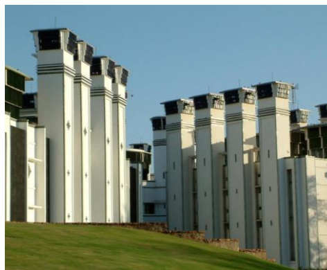
Figura 20. Torres de enfriamiento de planta baja a Nivel 2. Fuente: https://archnet.org/sites/4454/media_contents/17672
