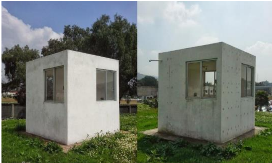
Figura 12. Módulo control y módulo de prueba. Fuente: Fernández 2015.
