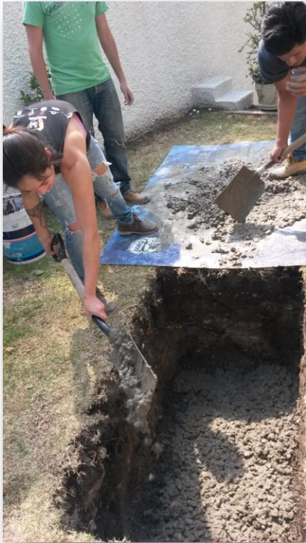
Vaciado de la mezcla en la plantilla
