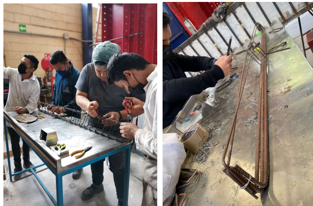
Figura 54. Colocación de estribos.
