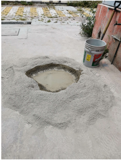
Figura 51. Hidratación del concreto.
