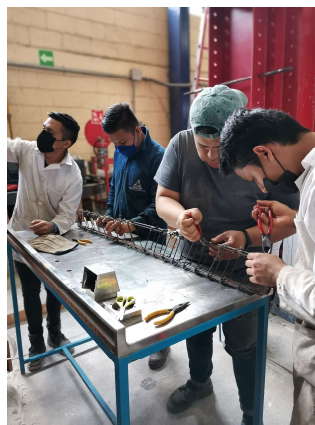
Figura 54. Colocación de estribos.
