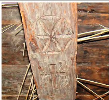
Antigua viga de techo con una «roseta» tallada para proteger a la casa del rayo (Skansen in Sanok, Polonia).
