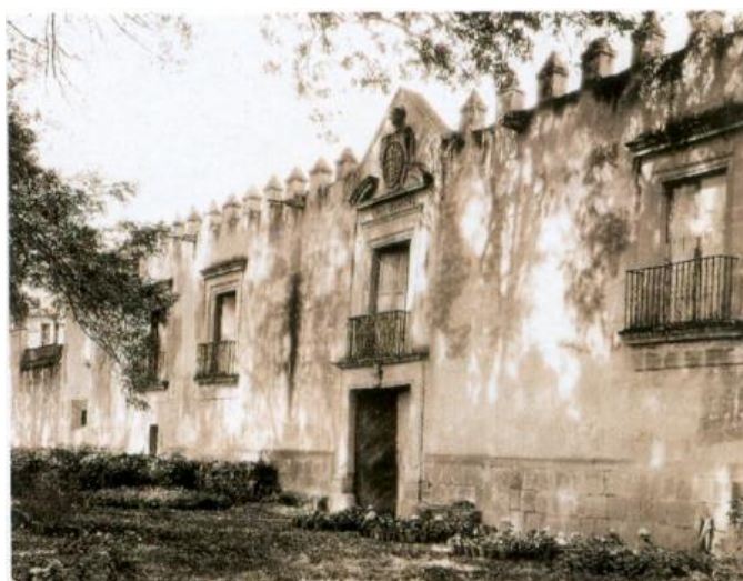
Fachada de la ex Hacienda San Antonio Clavería (tomado de: turimexico, 2014).
