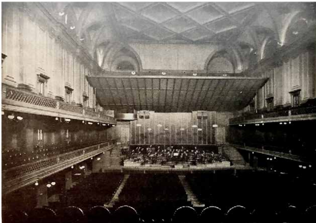
Interior de la antigua sala sinfónica de Bosto.
