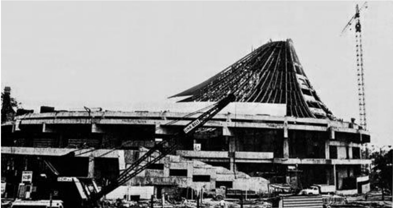
FIGURA 10.- En construcción (1976). Fuente: Revista Obras.
