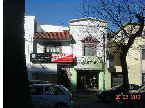
Inmueble en Av. Nuevo León #12, borde ote. de la Segunda Sección. Evidencian pérdida de autenticidad en uso de suelo, en proporción de vanos y en revestimientos. Foto del autor.
