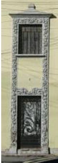
Detalle de agrupamiento por medio la continuidad de jambas en un inmueble Colonial californiano. Los relieves en argamasa imitan piedra.
