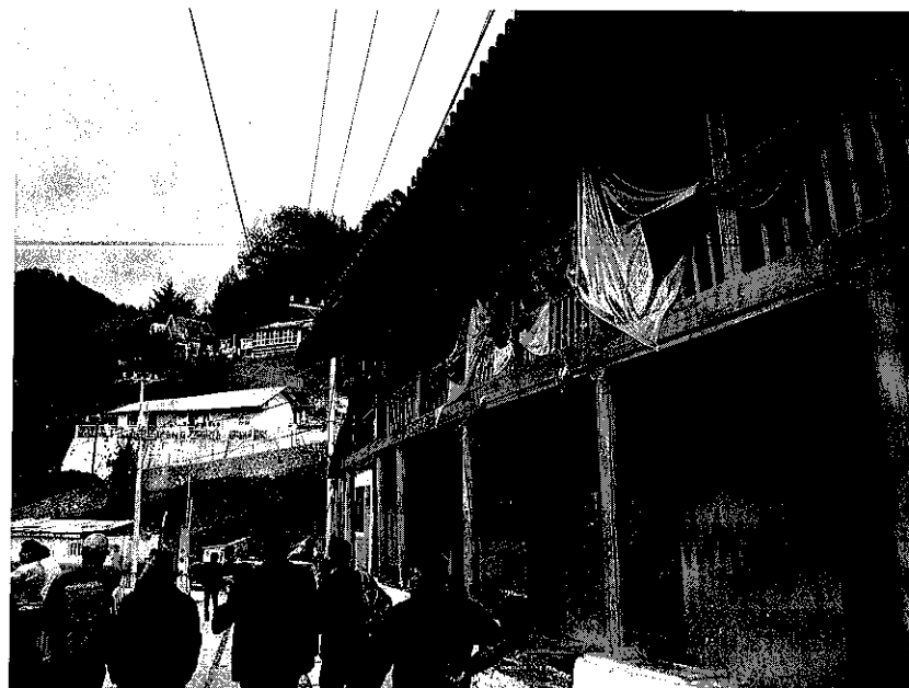
Vista desde calle Álvaro Obregón.
