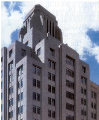
■ Edificio La Nacional, proyecto Arq. Manuel Ortiz Monasterio, Arq. Bernardo Calderón y Arq. Luis Ávila, D. F., 1932,
