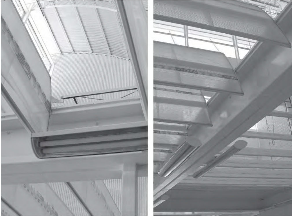
Fig. 74 Plafón con paletas translucidas giratorias.
