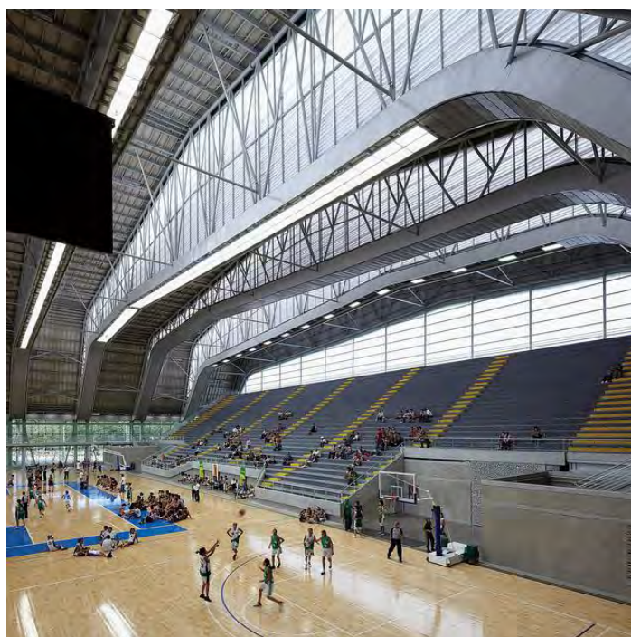
Fig. 62 Vista interior del coliseo de basquetbol
