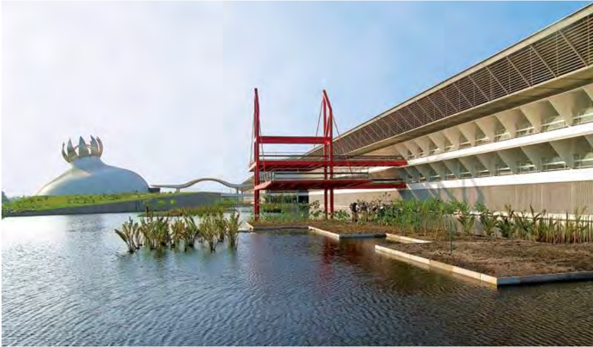
Fig. 76 Nótese los dispositivos de control solar que protegen a las ventanas.
