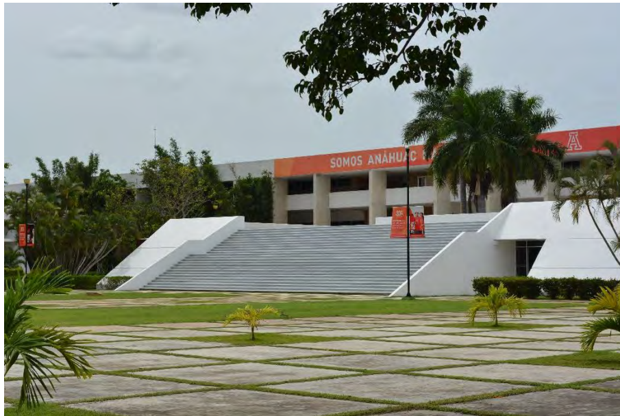
Fig. 60 Edificio 3. Fachada sur. Escalinata de acceso.
