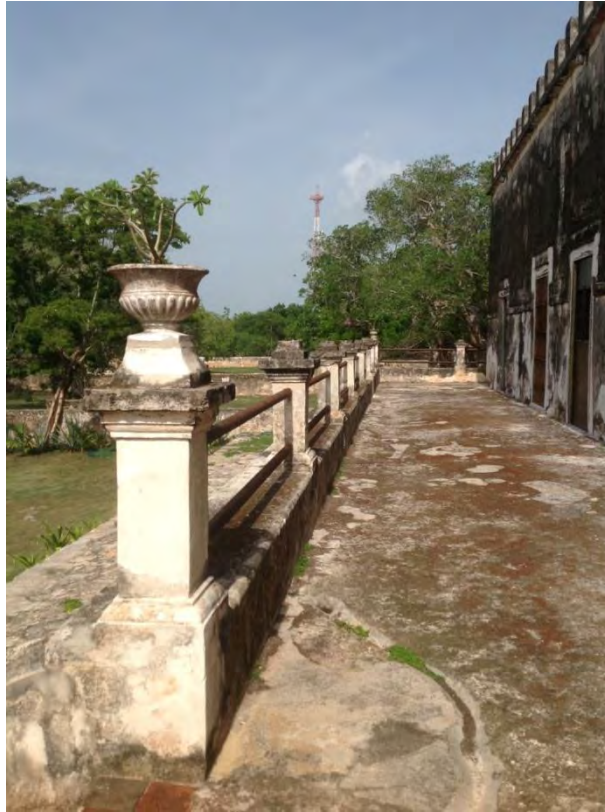
Fig. 49 Terraza exterior en fachada norte
