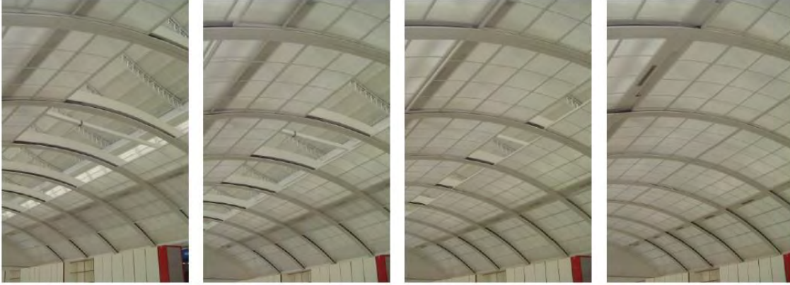
Fig. 69 Foto de cubierta con diferentes aberturas
