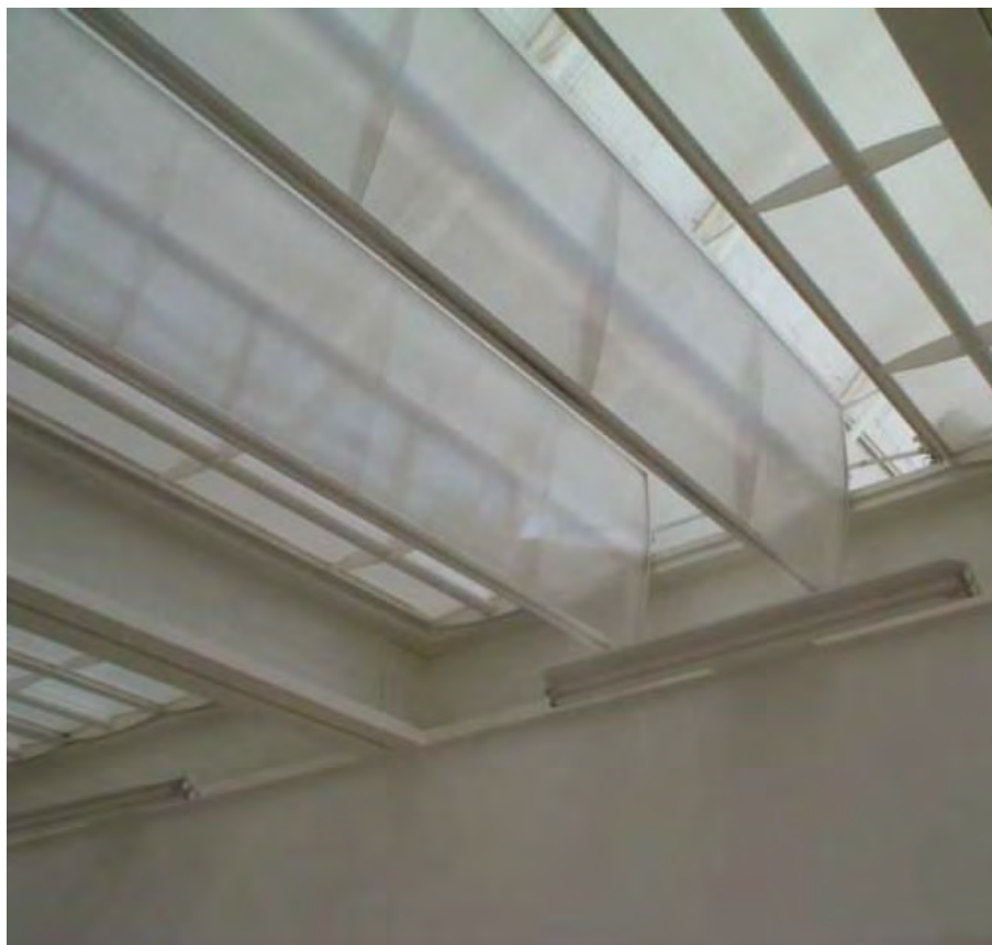
Fig. 72 Plafón de paletas giratorias abiertas
