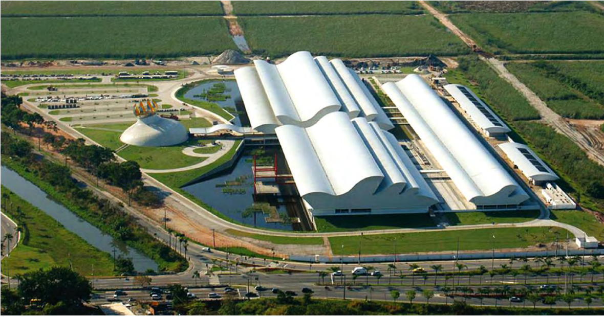
Fig. 78 Vista general del conjunto desde el sur
