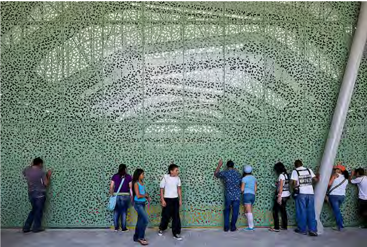
Fig. 60 Celosía de los coliseos que permite la ventilación cruzada de manera controlada
