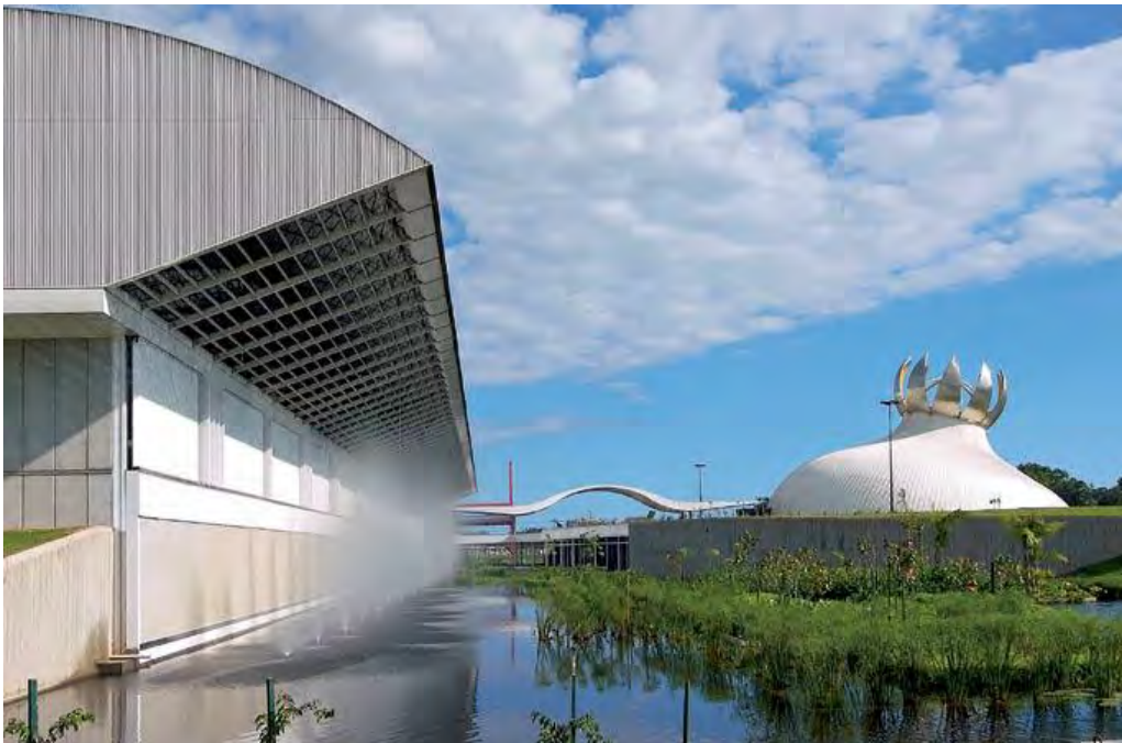
Fig. 75 Sistema de enfriamiento evaporativo
