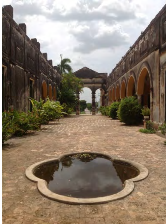
Fig. 46 Estanque para enfriamiento evaporativo
