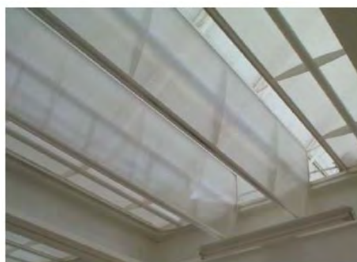
Fig. 73 Plafón de paletas giratorias cerradas y abiertas
