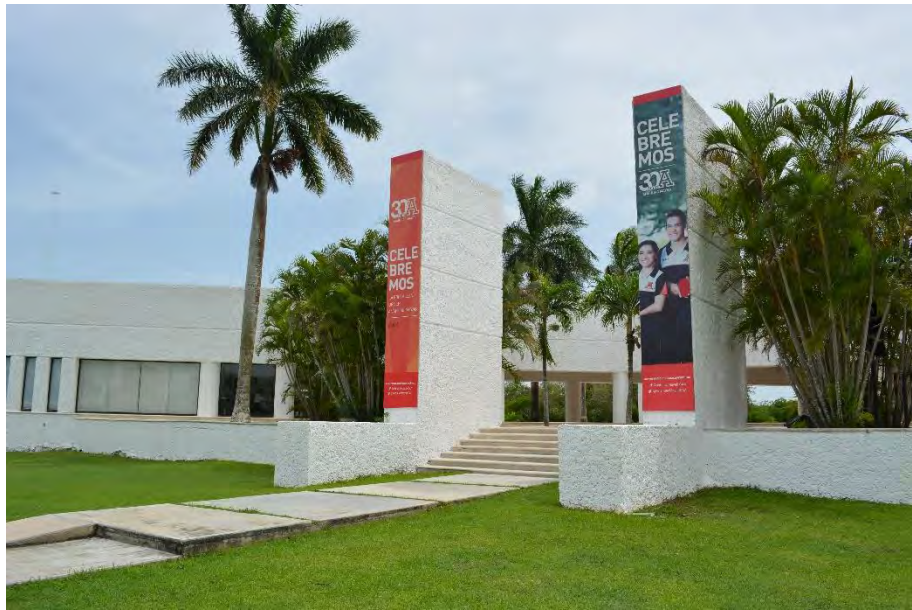
Fig. 56 Edificio de Rectoría, fachada norte.
