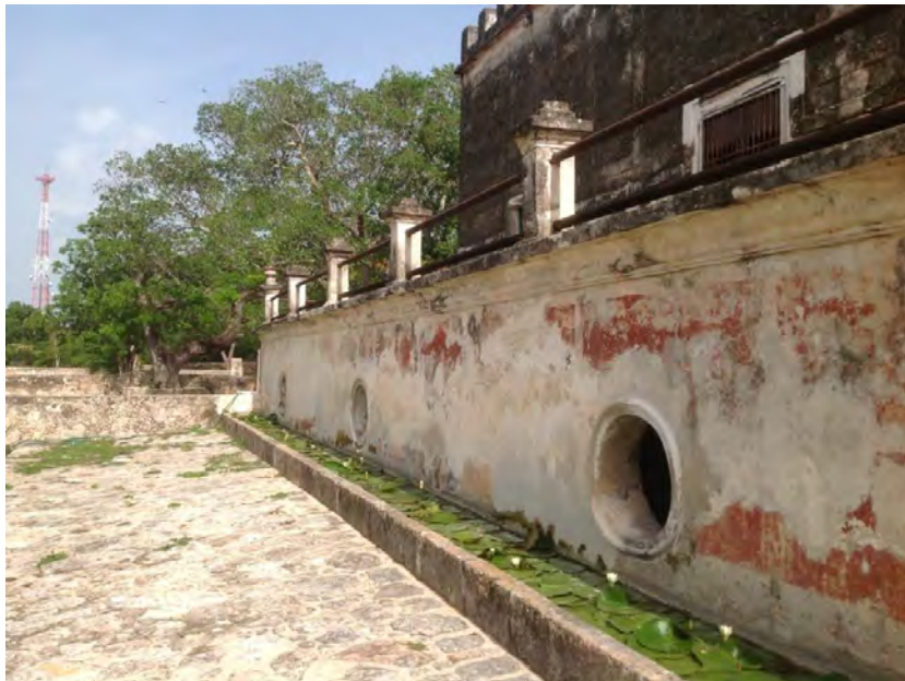
Fig. 50 Aljibes debajo de terraza en fachada norte
