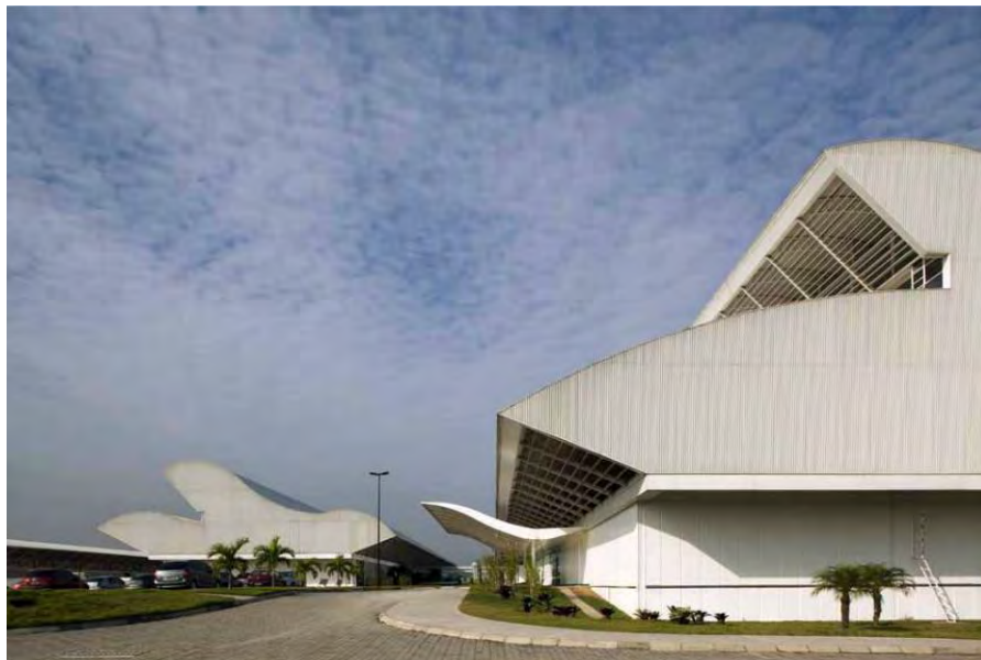
Fig. 81 Vista desde el norte. Al fondo edificio de servicios
