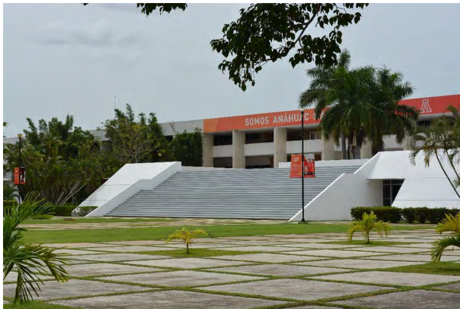
Fig. 60 Edificio 3. Fachada sur. Escalinata de acceso.
