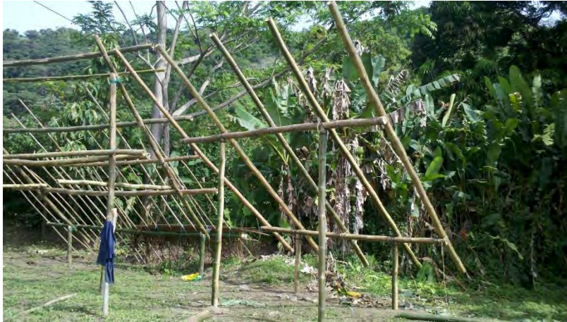
Fig. 45 Estructura básica del tapiri
