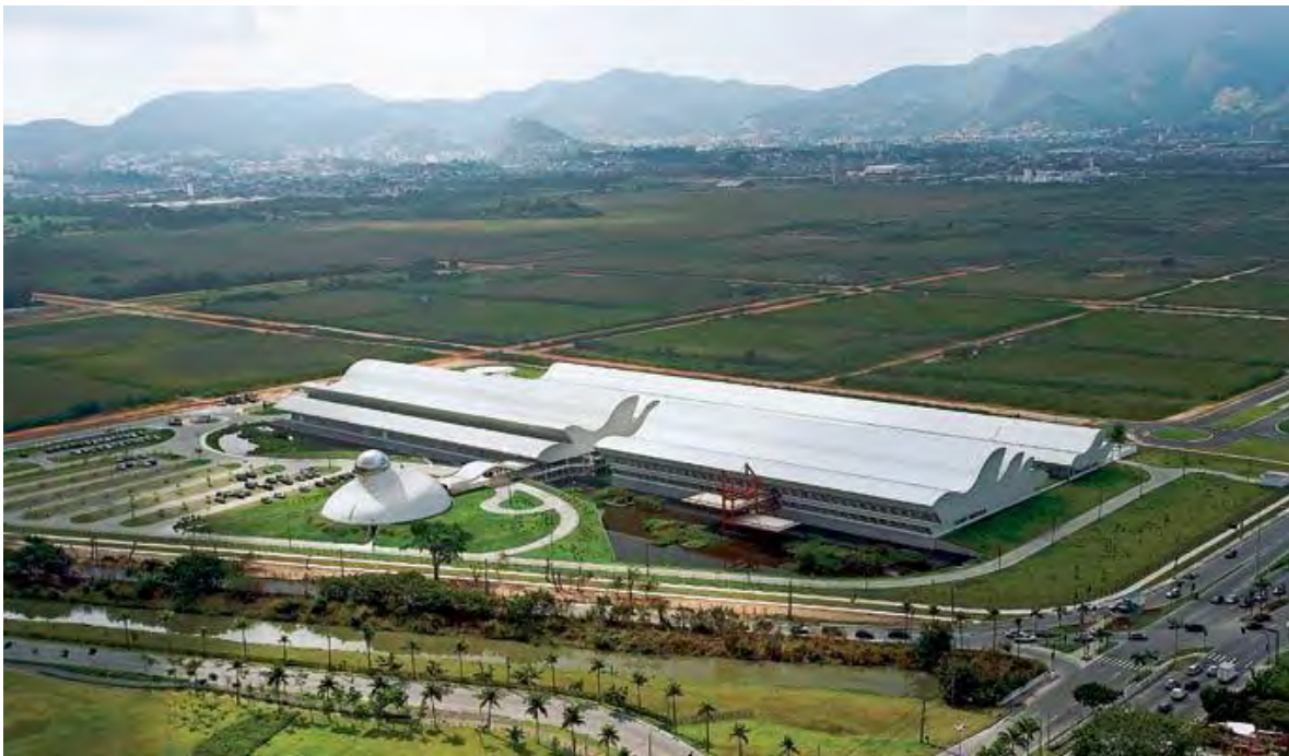
Fig. 77 Vista general del conjunto desde el poniente
