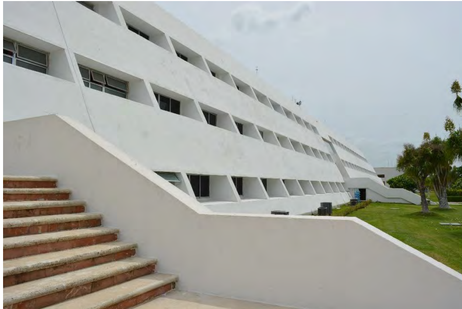
Fig. 59 Edificio 3. Fachada norte. División de Ciencias Jurídicas y Sociales
