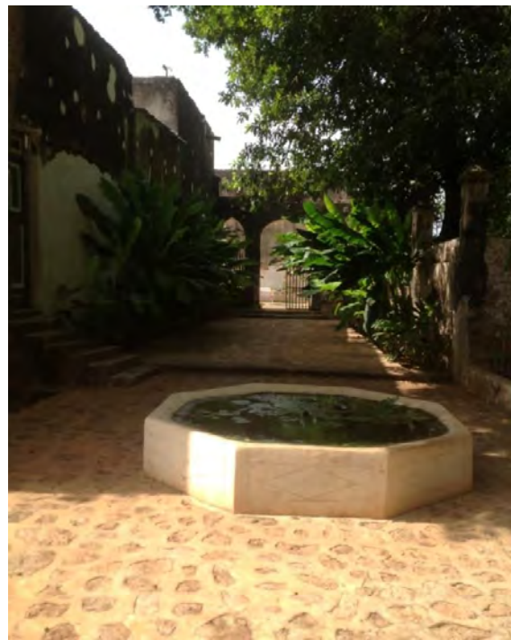
Fig. 47 Fuente para enfriamiento evaporativo
