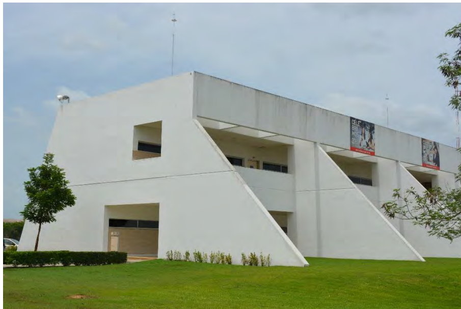
Fig. 58 Edificio 6, Fachada sur. Laboratorios de ingeniería y Comunicación y Diseño
