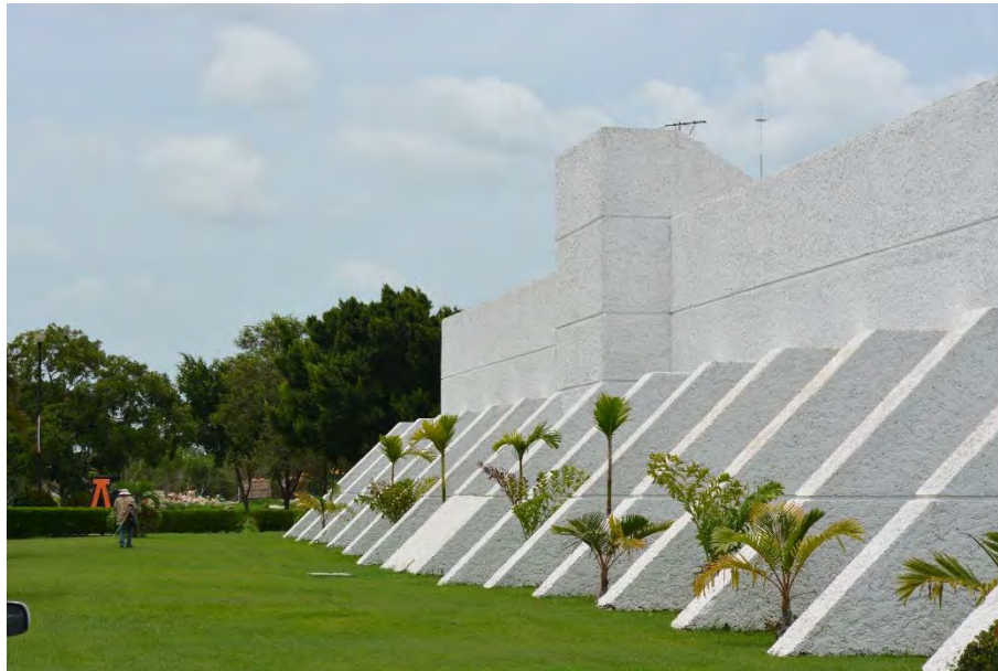
Fig. 54 Partesoles del edificio de Rectoría
