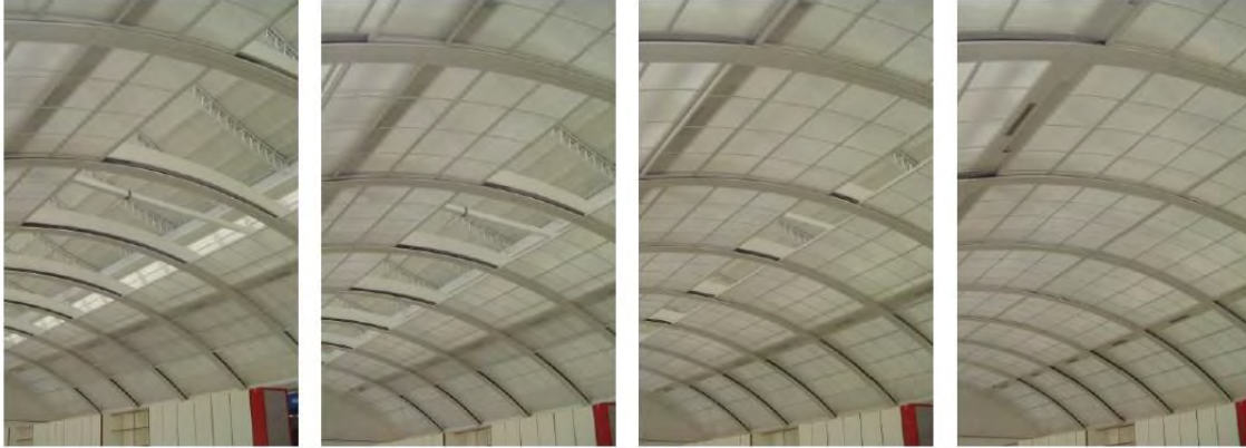
Fig. 69 Foto de cubierta con diferentes aberturas
