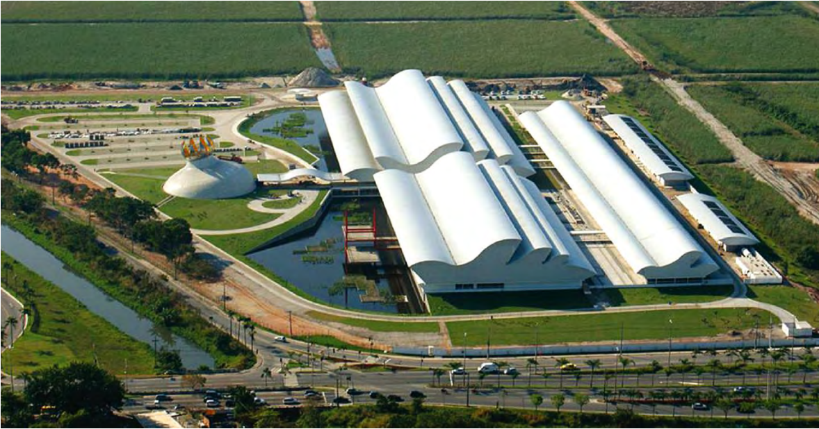
Fig. 78 Vista general del conjunto desde el sur
