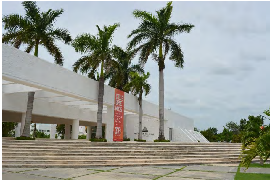
Fig. 55 Edificio de Rectoría, fachada sur, vista del pórtico de acceso.
