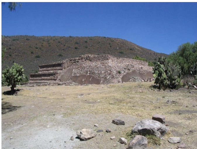
Fachada posterior del templo principal, en donde se aprecia un solo talud que sirve de soporte al edificio.
