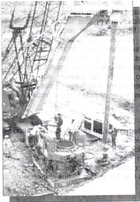
Si las condiciones del suelo son muy desfavorables pueden instalarse tubos de acero de gran diámetro, por un procedimiento en que se combinan los métodos de hincado de pilotes y la excavación abierta. Los tubos se hincan con los extremos abiertos, unos cuantos metros cada vez y se limpia el interior por medio de chorros de aire, de agua o herramienta de cable. Estas perforaciones se llevan hasta la roca o capa más resistente de desplante.
