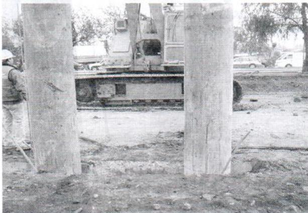
y hacerla excavar, el ancho de la herramienta corresponde al ancho de la zanja, se construyen generalmente mediante tableros alternados de 2.50, 5.00, y 7.50 metros de ancho; su profundidad depende del problema en cuestión.
