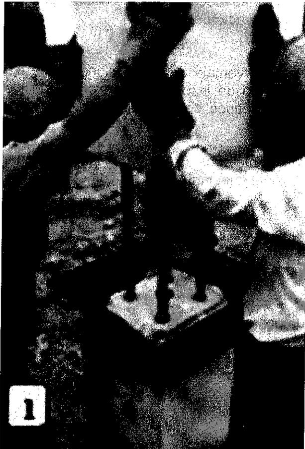
Esta junta consiste en dos casquillos metálicos que se colocan durante el colado en los extremos de los tramos de pilote por unir y para fijarlos más firmemente al concreto se les soldan anteriormente a los casquillos anclas metálicas y posteriormente se soldan con una o más cordones de soldadura.
