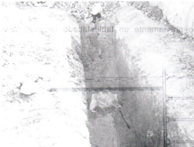
Ahora el problema no es bajar el nivel freático, que baja por sí solo simultáneamente con el fondo de la excavación, sino el controlar el flujo del agua hacia la excavación, que, aunque no llegue a inundarla.
