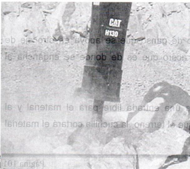
Los martillos neumáticos son piezas de menor magnitud que pueden ser auxiliares en una excavación, pues realiza con más precisión una excavación que un tras cavo. Son utilizadas en terrenos duros y sobre todo cuando
