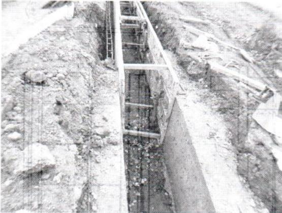
construcción de edificaciones pueden realizarse a gran profundidad, independientemente de la mala naturaleza de los terrenos encontrados, realizándose por medio de muros moldeados in-situ, el sistema más conocido de estos se conoce como muro Milán.
