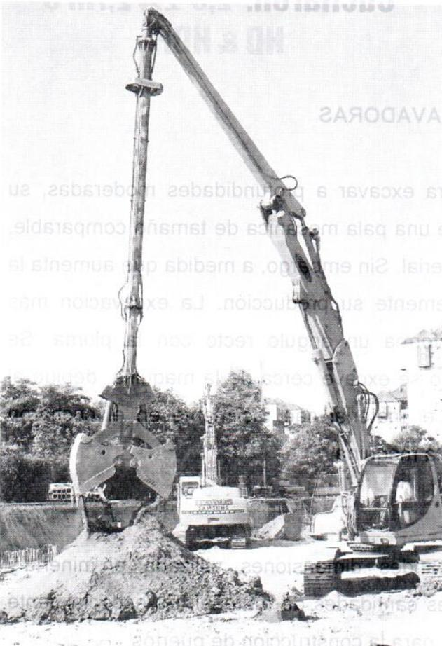
El cucharón bivalva es la herramienta específica para este trabajo, con el que se consigue excavar únicamente el volumen de tierra necesario, en vertical, quedando las paredes laterales totalmente verticales y no moviendo tierra que luego no es de utilidad
