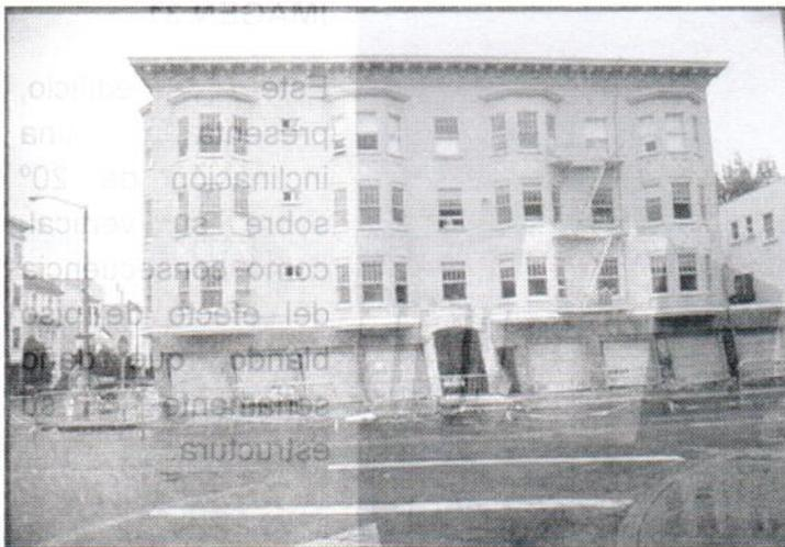
Se observa un gran desplazamiento lateral de la planta baja, que ha arrastrado al resto del edificio sin que aparentemente haya sufrido más daños. Es un caso de "piso blando", sin llegar al colapso, pero con graves daños estructurales.
