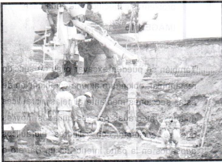
Es normal que quede un poco de material suelto en el fondo del barreno, durante una buena construcción de pilas normalmente implica excavar el barreno en el menor tiempo posible y colocar enseguida el concreto.
