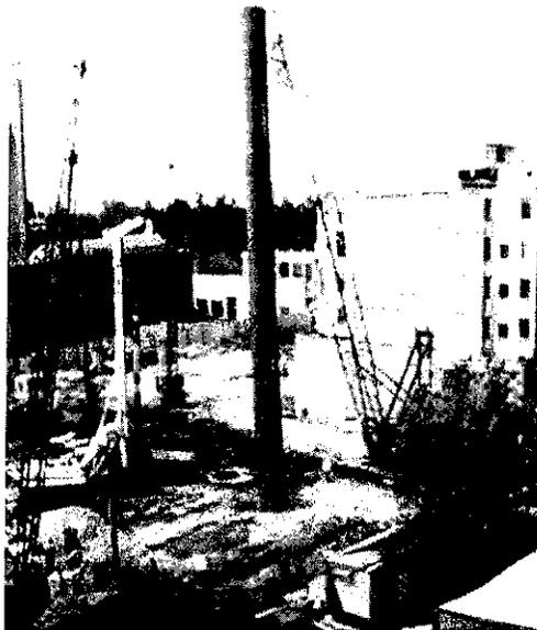
La cota superior del concreto deberá quedar por encima de la del proyecto de la pila con el fin de demoler este exceso ya que esta parte es la que siempre estará en contacto con el lodo bentonítico y en consecuencia está contaminada ocasionándole gran reducción en la resistencia a la compresión.
