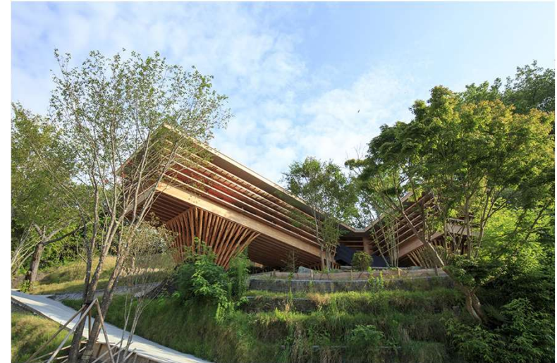
Figura 37. Casa en Itsuura, ADX, Japón, Arch Daily. Fuente: www.archdaily.mx/mx ; 2020.
