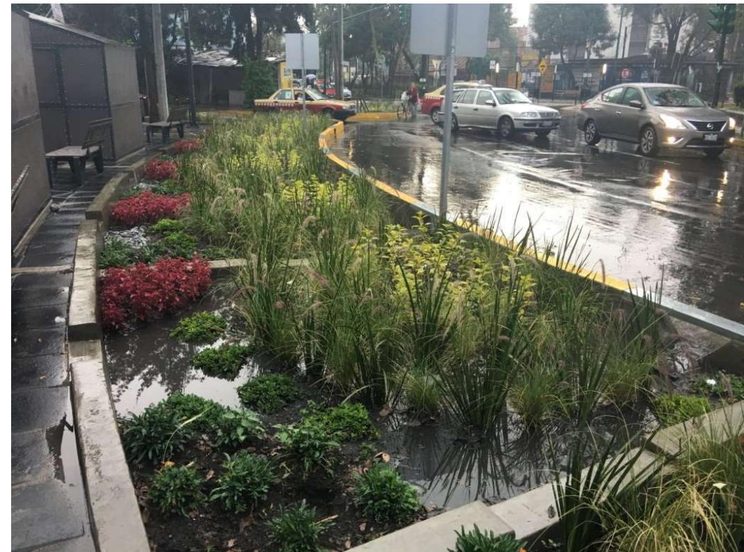
Figura 64, 65. Fotos actuales de como funciona el jardín de lluvia Legaria Fuente: www.eetestudio.com ; 2020.
