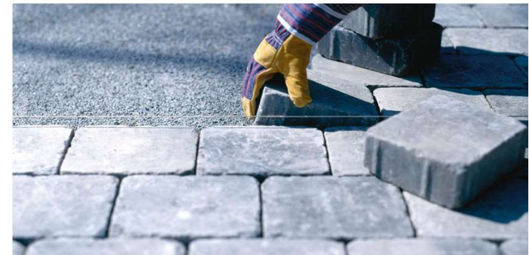
Figura 70. Colocación de pavimento. Fuente: www.breinco.com ; 2020.
