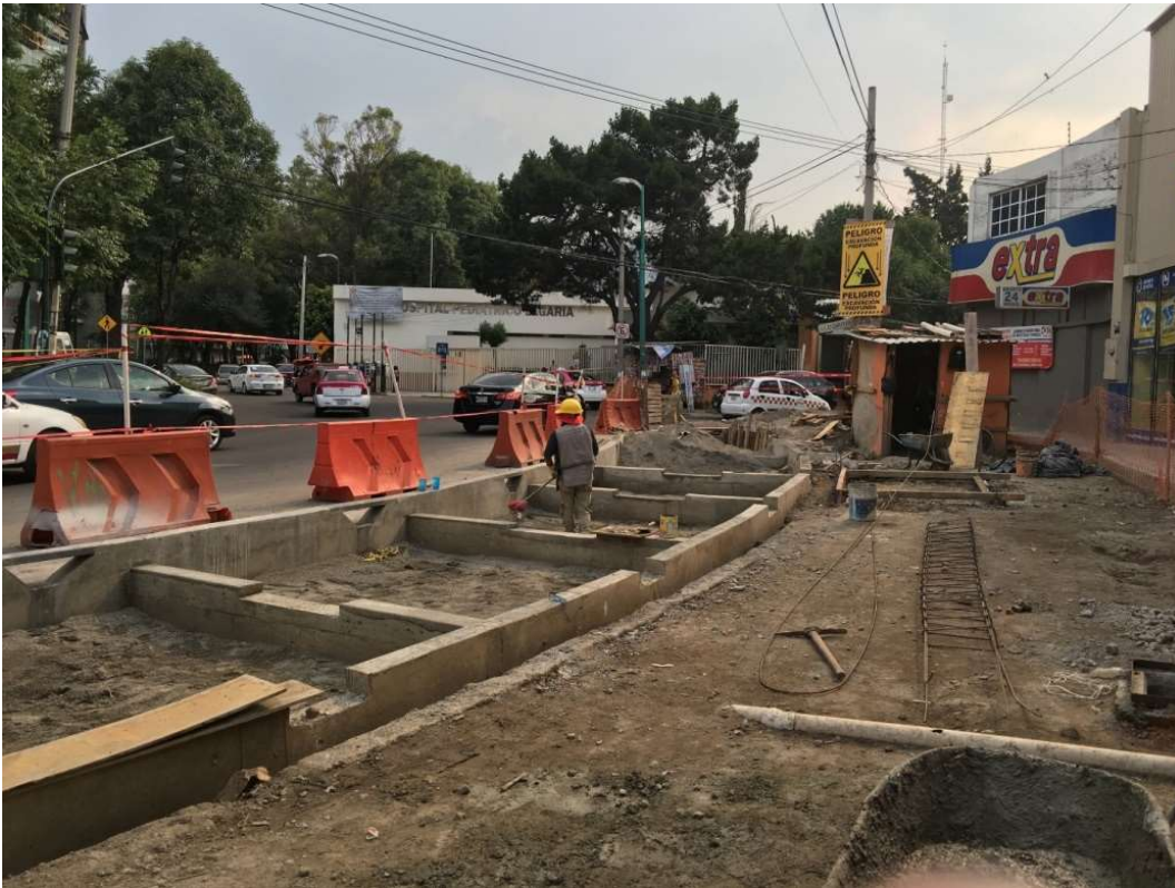
Figura 62, 63. Proceso constructivo del jardín de lluvia Legaria Fuente: www.eetestudio.com ; 2020.
