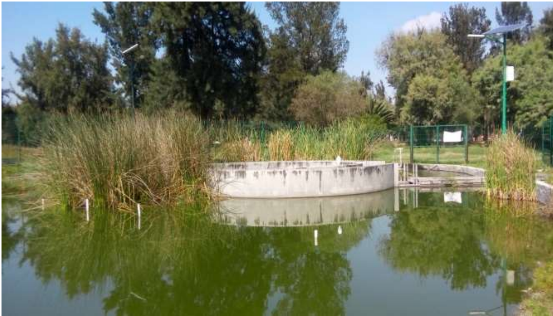
Figura 44. Tanque de sedimentación en el Humedal Artificial del Bosque de Aragón Fuente: Vélez, D., noviembre 2019.
