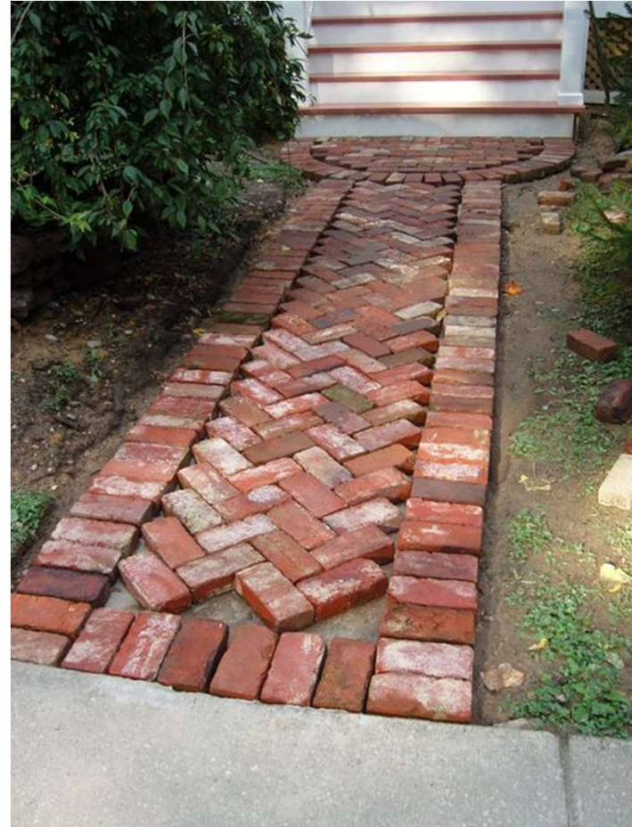
Figura 38. Pavimento a base de ladrillos. Fuente: www.pinterest.com.mx ; 2020.
