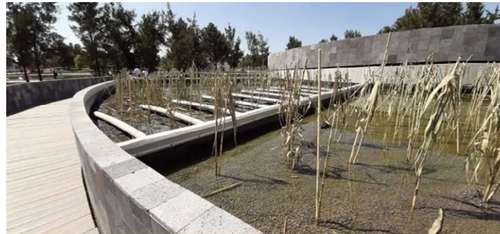
Figura 54. Humedal subsuperficial en el norte del Bosque de Aragón. Fuente: Reyes D., febrero 2020.
