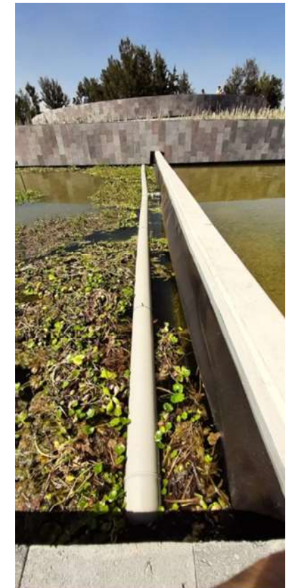
Figura 57. Conducción del agua en el Humedal norte del Bosque de Aragón Fuente: Reyes D., febrero 2020.
