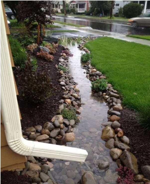
Figura 36. Complementos del Jardín de Lluvia: a) bajante del agua pluvial; b) recorrido del agua, y c) registro de drenaje. Fuente: www.lavozdelmuro.net ; 2020.
