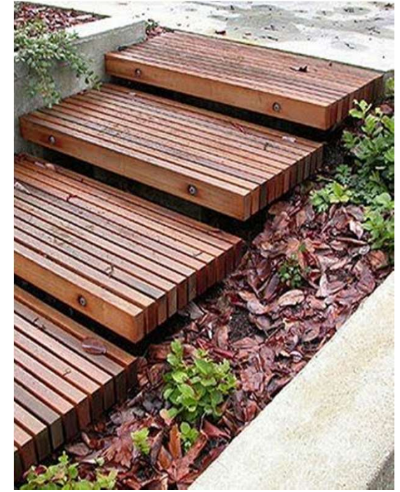
Figura 6. Escalera realizada con madera en segmentos., Archi Dia. Fuente: www.Pinterest.com ; 2020.
