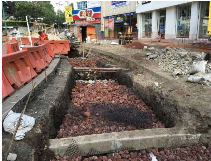
Figura 59, 60, 61. Proceso constructivo del jardín de lluvia Legaria Fuente: www.eetestudio.com ; 2020.
