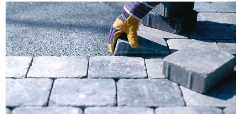
Figura 70. Colocación de pavimento. Fuente: www.breinco.com ; 2020.
